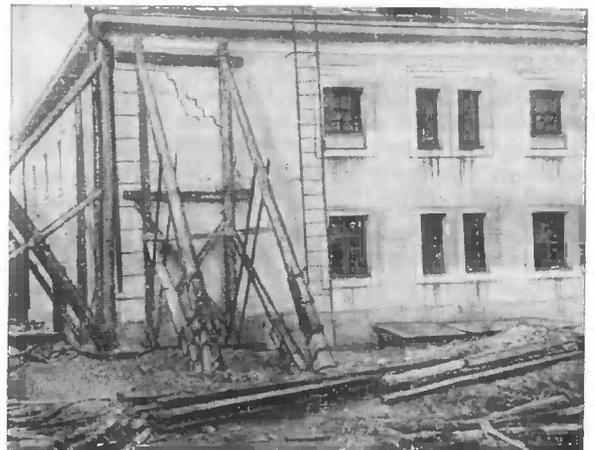
Рис. 2. Трещины здания в поселке Мянуджа, Магаданской области
