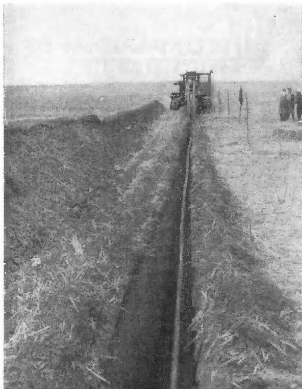
Строительство закрытого дренажа многоковшовым экскаватором. Латвийская ССР
